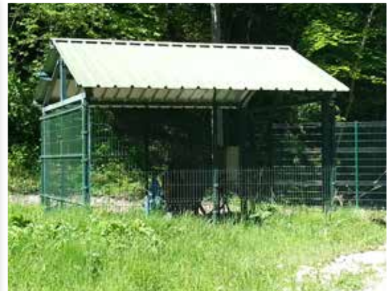
Pompage de la nappe phréatique de Chez Grillet
